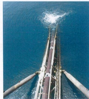
Hình 1.11 Hoạt động lắp đặt tuyến ống ngoài khơi
